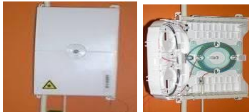
Point de branchement en immeuble
