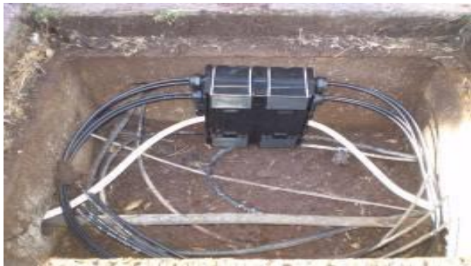
Point de branchement en chambre
